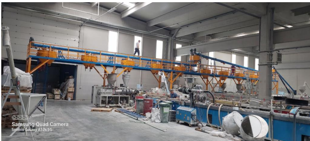
Slika 7. Prikaz faze montaže sistema za otprašivanje “Yavuz Company” d.o.o. Srebrenik, PJ Brčko
