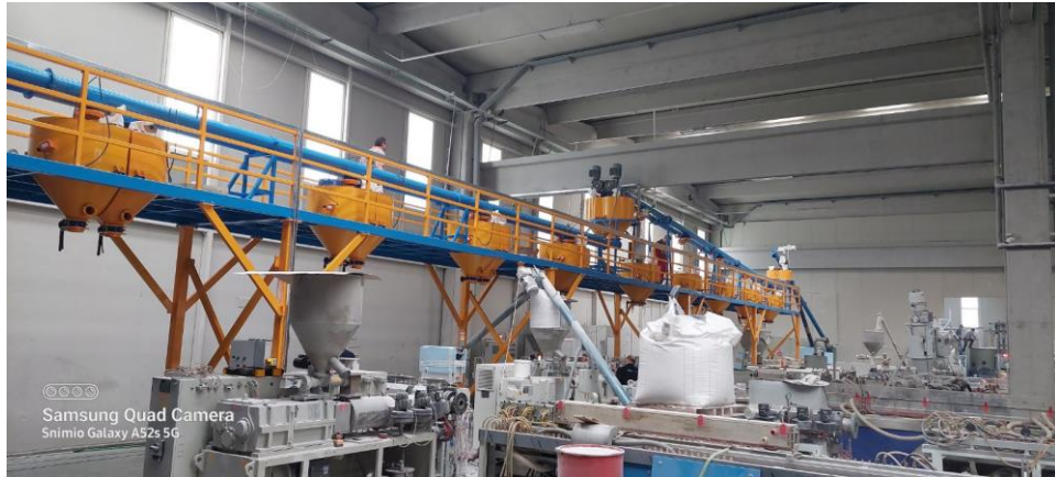
Slika 8. Prikaz faze montaže sistema za otprašivanje “Yavuz Company” d.o.o. Srebrenik, PJ Brčko
