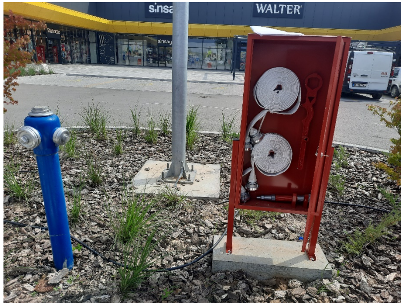
Слика 28. Вањски надземни хидрант на предметној локацији
