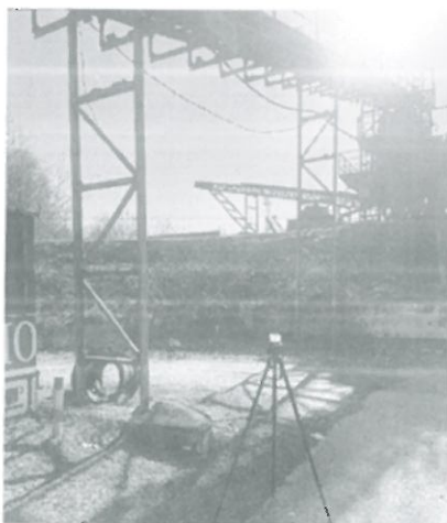
Slika 1: Mjerenje vanjske buke u eksploatacionim uslovima
